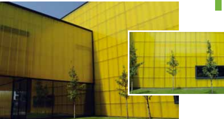
Moderne Fassadengestaltung. Alles ist möglich
